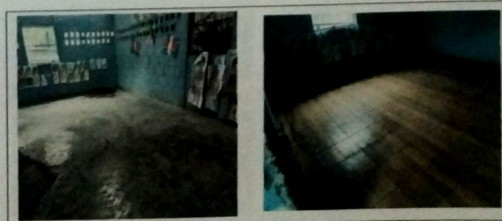
Foto 12: MODULO DE AULAS Instalacion de piso ceramico
